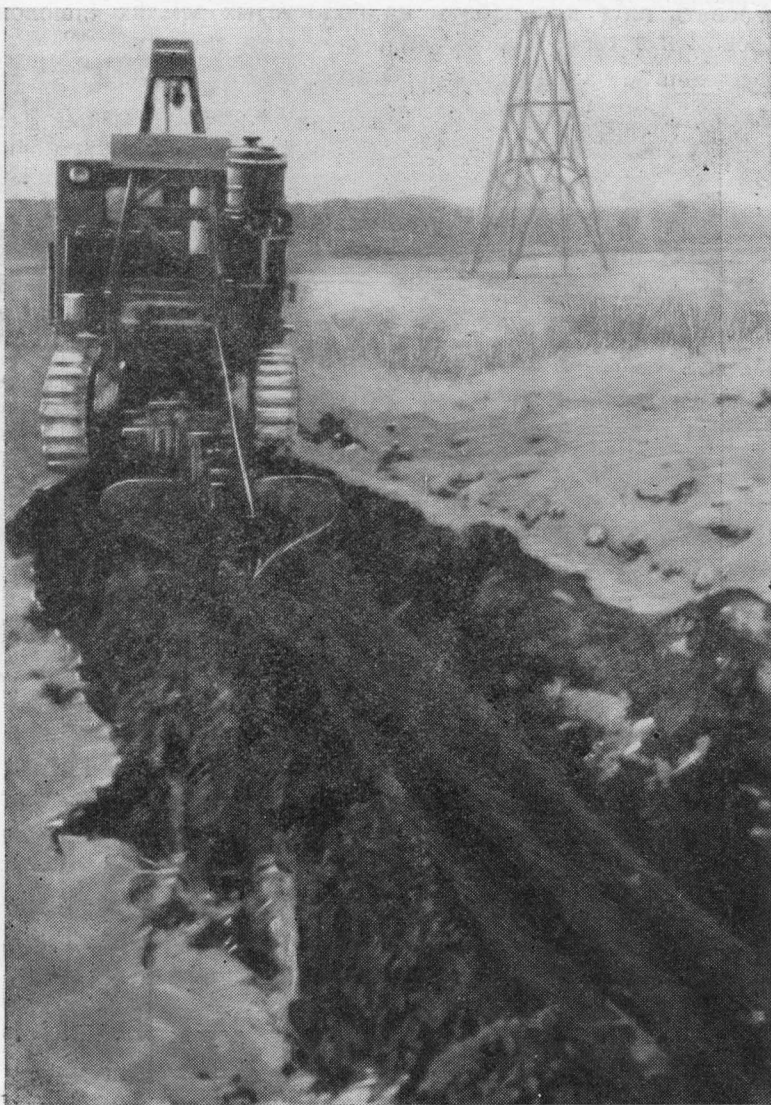
Рис. 12. Навесной двухотвальный плуг на тракторе КТ-12.
