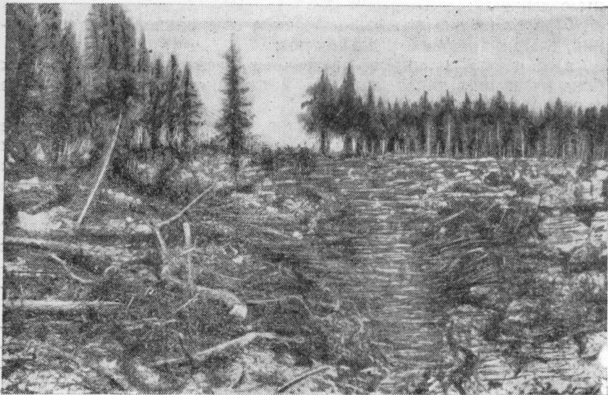
Рис. 17. Неочищенная лесосека после трелевки леса с частично обрубленными сучьями лебедками Л-19.
