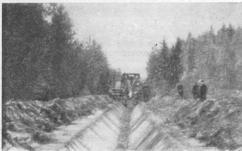
Рис. 16. Канавы, проложенная канавокопателем ЛКА-2.
