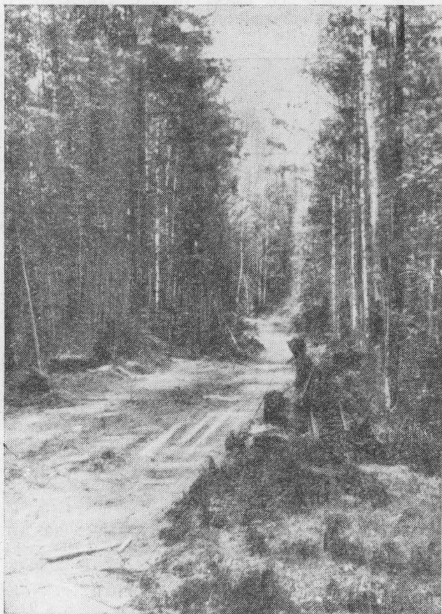
Рис. 14. Защитная полоса, созданная бульдозером.
